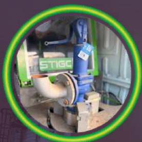
TARATURA VALVOLE DI SICUREZZA
